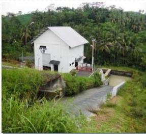
Siteki 1,2 MW Mini Hydro Plant, grid connected
